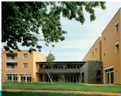
IAMI - NACARAT Bâtiment de communauté et centre de soin, ECULLY
