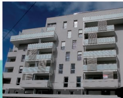
COGEDIM/NEXITY - LE CHARLESTON 117 logements, LYON 7 ME
